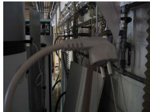
018 Reconnect the plug. Please be sure that all the functions for the heat Pump is correct. Eventually adjustment must take place. (Heating element / Boiler, air speed. Etc.) 018 Netstecker einsetzen. Kontrollieren Sie dann die Funktionen der WP Eventuell Einstellung ändern. (Heizstab / Kessels, Luftgeschwindigkeit usw.)
