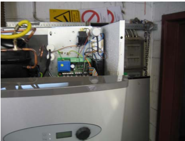
004 Remove the door. Remove the 2 screws. 004 Tür Entfernen. 2 schrauben entfernen.
