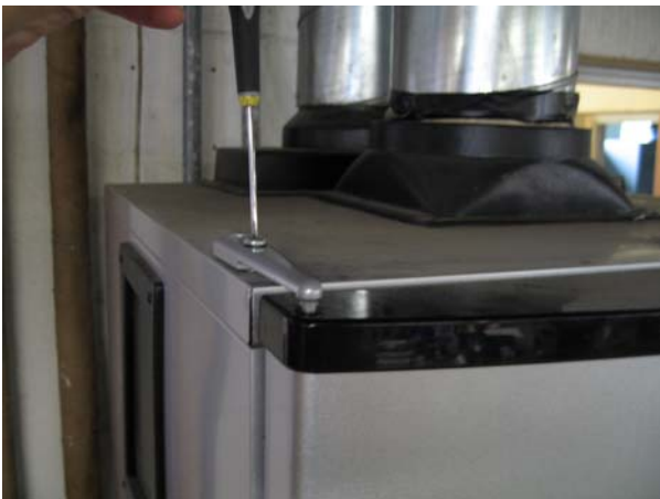
017 Remount the fittings for the top plate. 017 Beschlag oben anschrauben.
